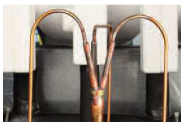
Urządzenie rozprężne — kapilara
