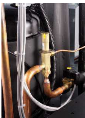
Przewód obejściowy gorącego gazu
