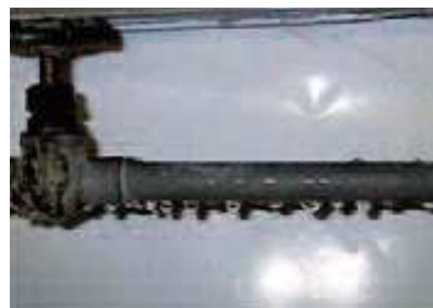
Wilgoć skraplająca się na zewnątrz przewodu sprężonego powietrza (pocenie)
