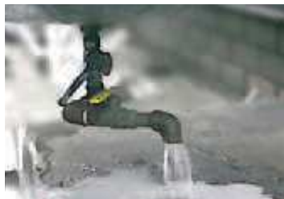
Nieuzdatnione sprężone powietrze nie zapobiega gromadzeniu się dużych ilości wody w zbiornikach powietrza i dalszej części orurowania.
